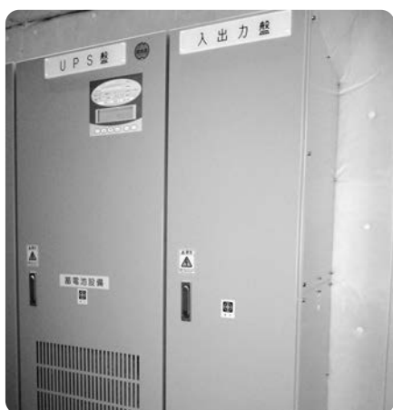
無停電電源装置 (UPS)
