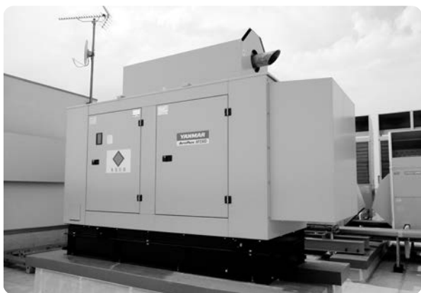
自家発電装置
